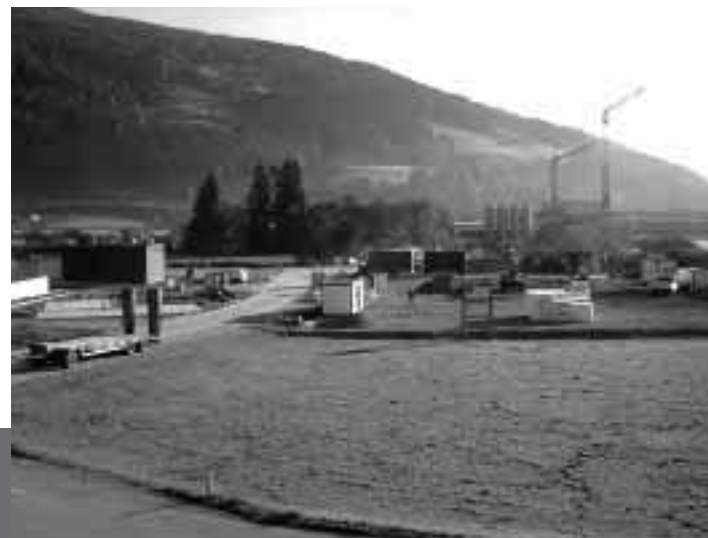
Das Gewerbegebiet „Ennsbogen“ ist im Entstehen.
